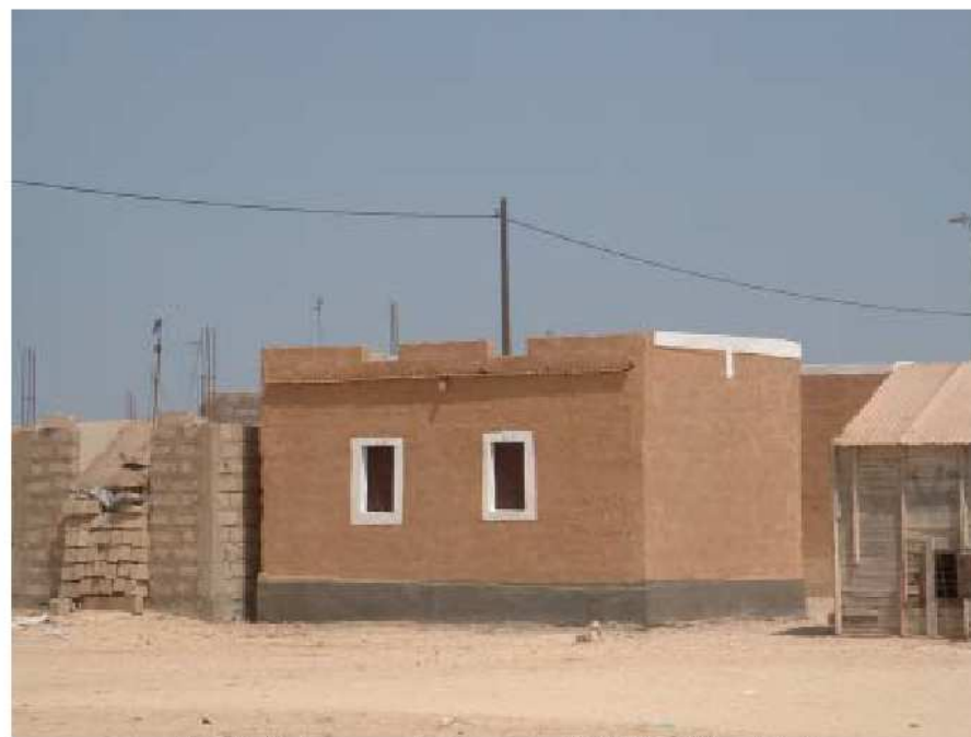
Module Twize, zone de recasement à El Mina, Nouakchott
